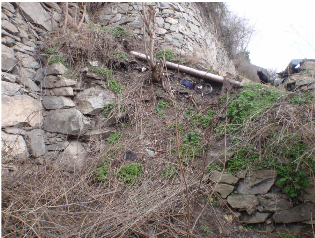
Pohled na destruovanou navazující příčnou část opěrné stěny, oddělující výše položený sousední pozemek.
