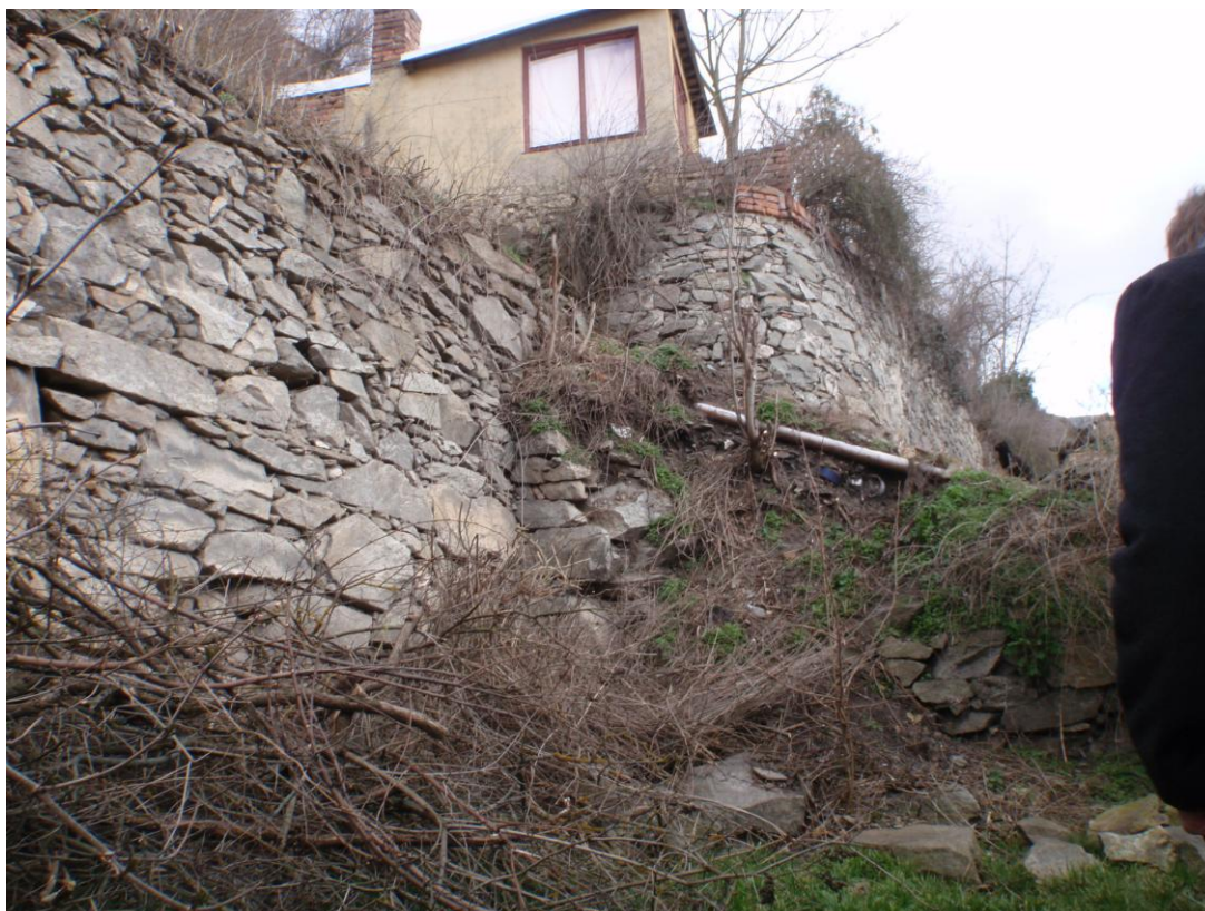
Výška havarované části opěrné stěny byla do 2,5 m.
