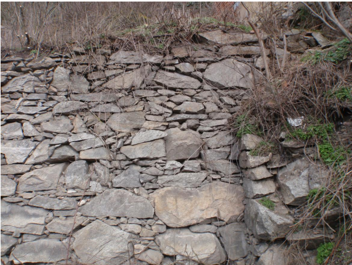
Stěna je tvořena lomovým kamenem, maximální výška dosahuje 3,0 m.
