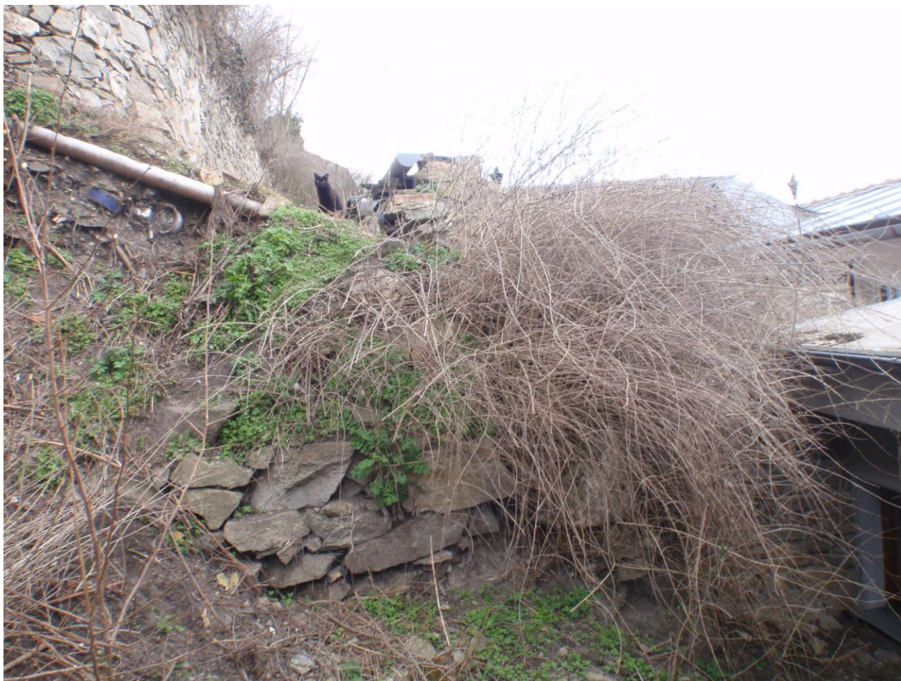
Negativní vliv na stěnu má i prorůstající kořenový systém vegetace dřikem stěny.
