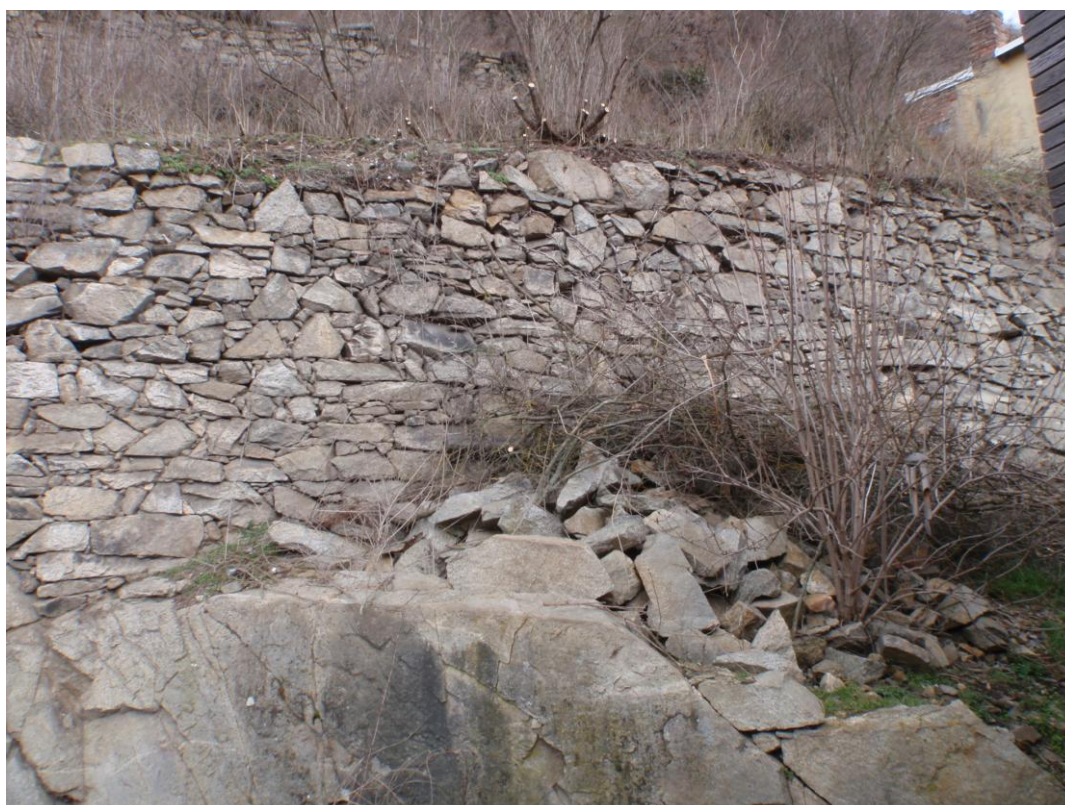
Stěna je narušena jednak liniovým rozpadem koruny, tak i dlouhodobým vyplavováním pojiva.
